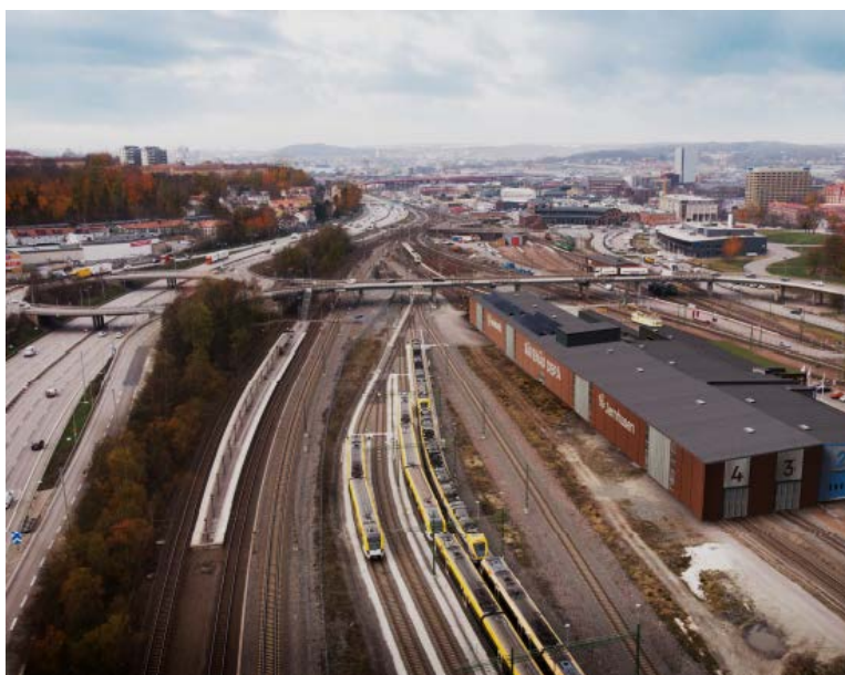
Bild: Sävenäsdepån efter planerad ombyggnad
