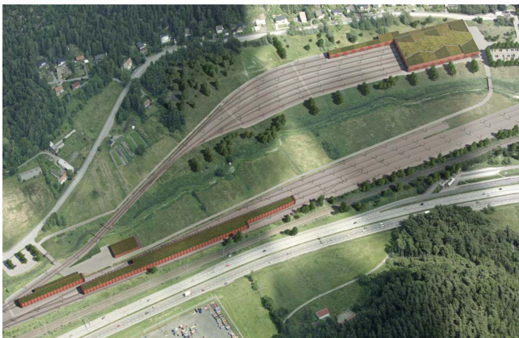
Bild: Sandbäcksdepån och ny uppställningsbangård Pilekrogen
