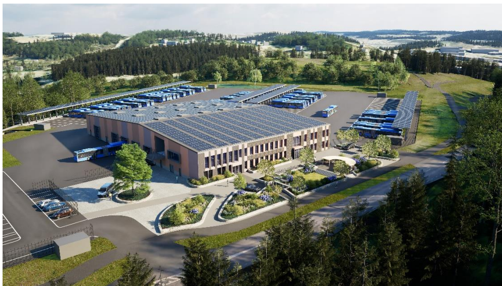
Bussdepå Rösered sedd från söder
