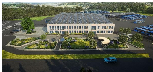
Depåbyggnaden och -området från sydost
