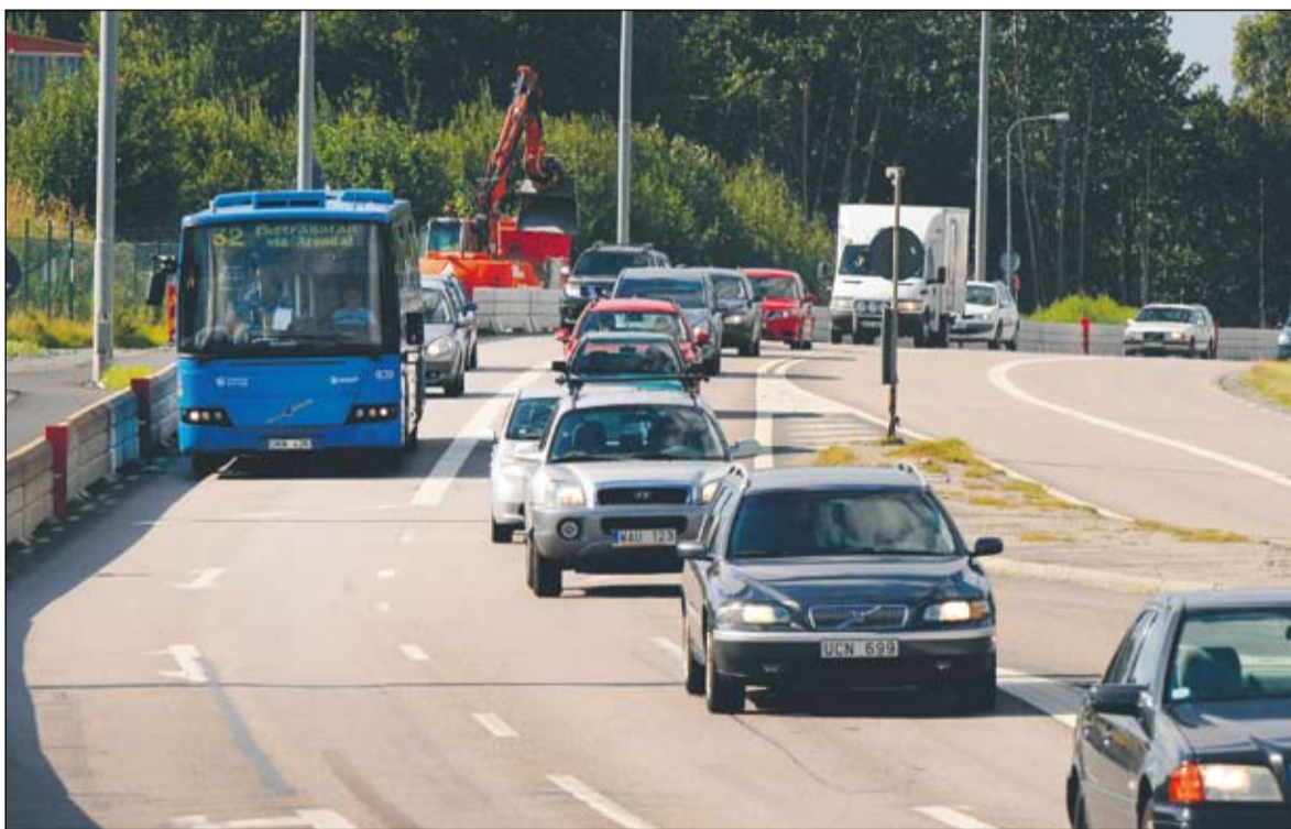
Arbete pågår. 2014 väntas arbetet med att bygga om 155:an till sexfältig väg vara helt klart. Under tiden är ett körfält i vardera riktning vikt åt bussar, samåkare och tung trafik – allt för att uppmuntra resande att inte åka en och en.
