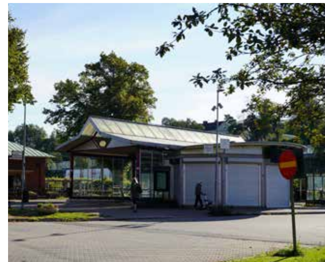
Tak, trappa, hiss och vänthall från 1993
