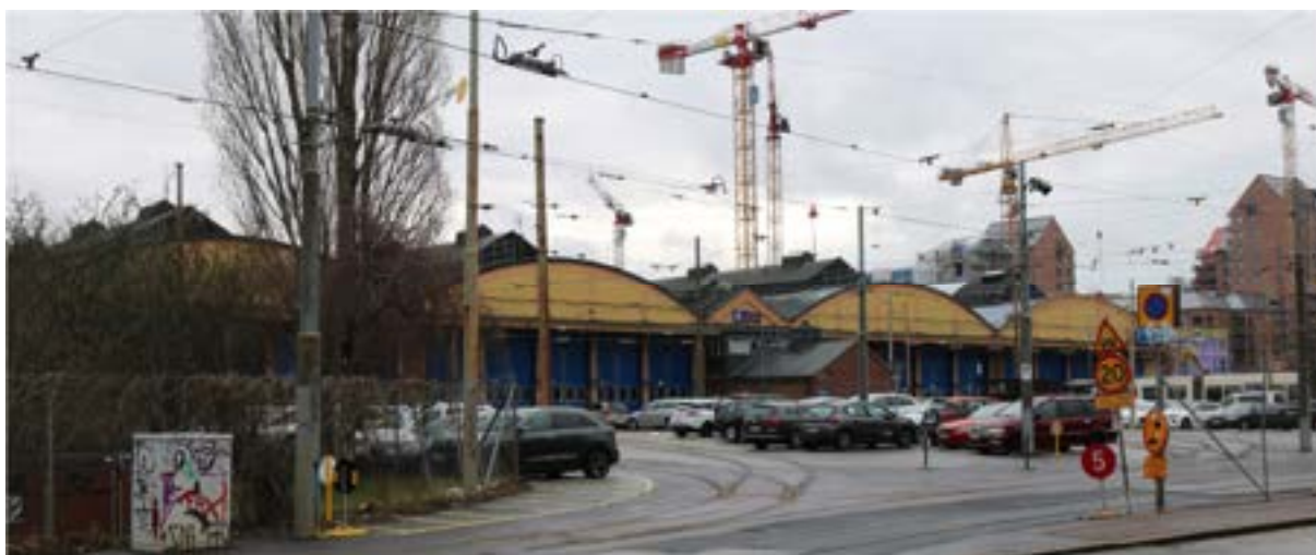
Figur 11. Bilden är tagen från Karl Johansgatan och visar befintligt gavelmotiv mot nordväst. Fönstren ovanför portarna är igensatta med plåt. I bakgrunden skymtar ny bebyggelse på Fixfabriken.
